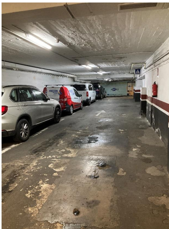
Fotografía nº 13: Desgaste pavimento y humedades en forjado
