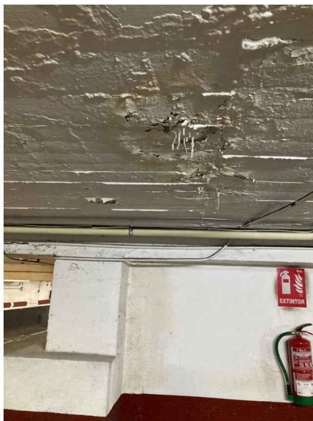
Fotografía nº 9: Detalle humedades losa cubierta
