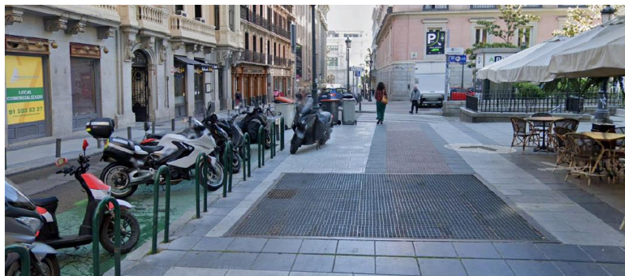
Fotografía nº 26: Rejilla de hueco de ventilación en planta de urbanización exterior
