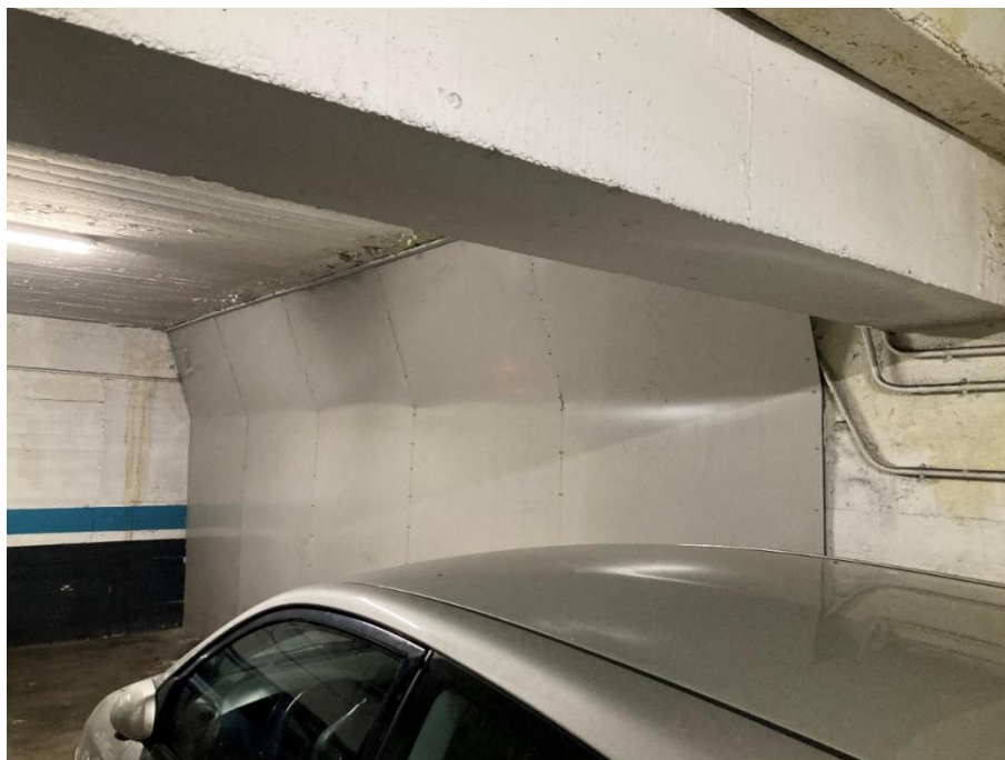
Fotografía nº 13: Panel ocultando humedades del muro perimetral zona- esquina inferior derecha, planta S-2
