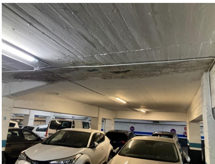
Fotografía nº 20: Humedades en viga en planta S-2, bajo rampa de acceso
