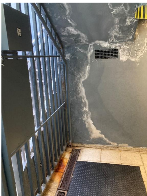
Fotografía nº 4: Humedades en el aplacado exterior y paramentos interiores junto a la escalera de acceso
