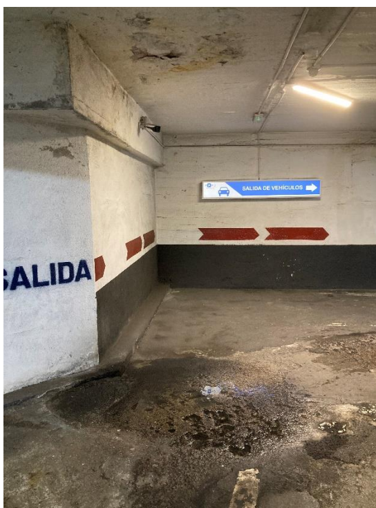
Fotografía nº 11: Desgaste pavimento y acumulación de agua
