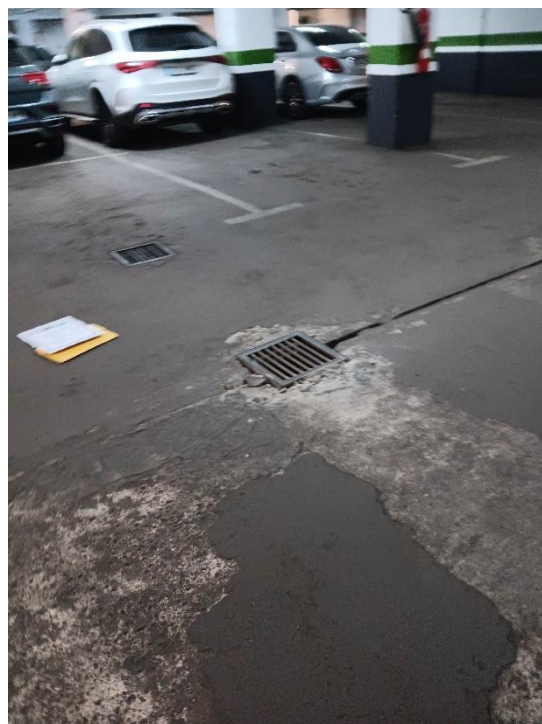
Fotografía nº 32: Desgaste pavimento. Abertura de la línea de saneamiento
