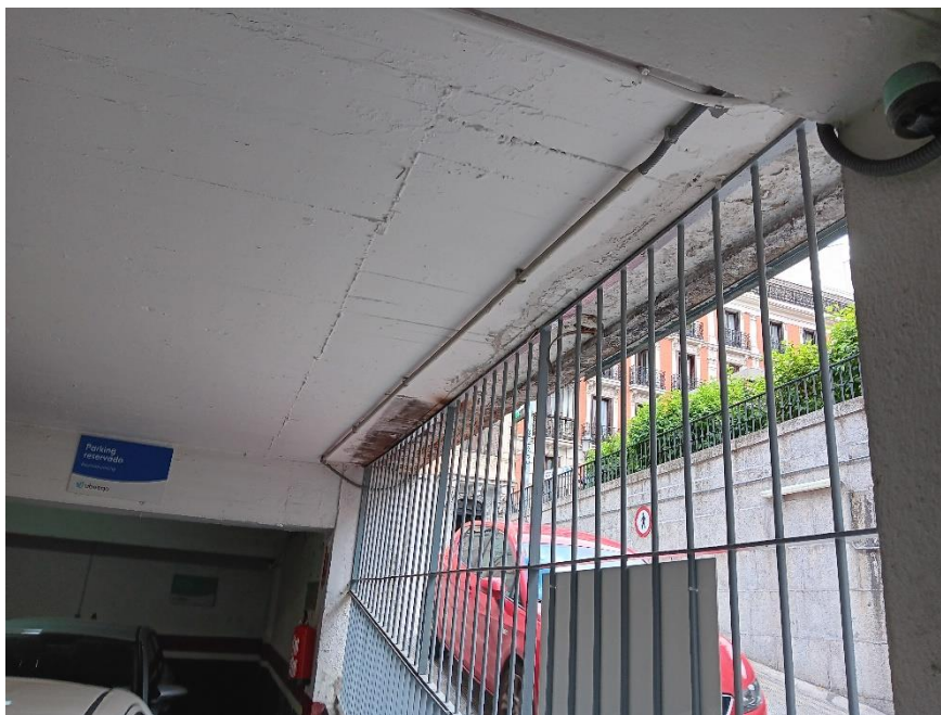
Fotografía nº 3: Humedades en muro de cierre de la rampa de acceso al aparcamiento
