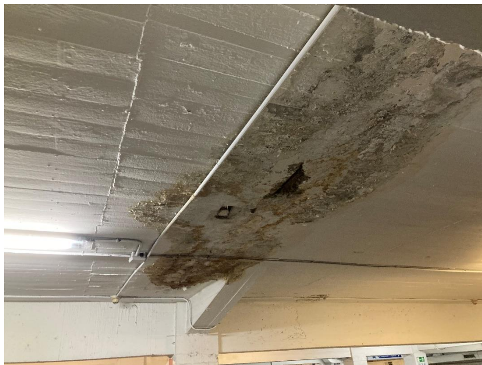
Fotografía nº 17: Detalle de humedades en forjado planta S-2 y pérdida de recubrimiento del hormigón
