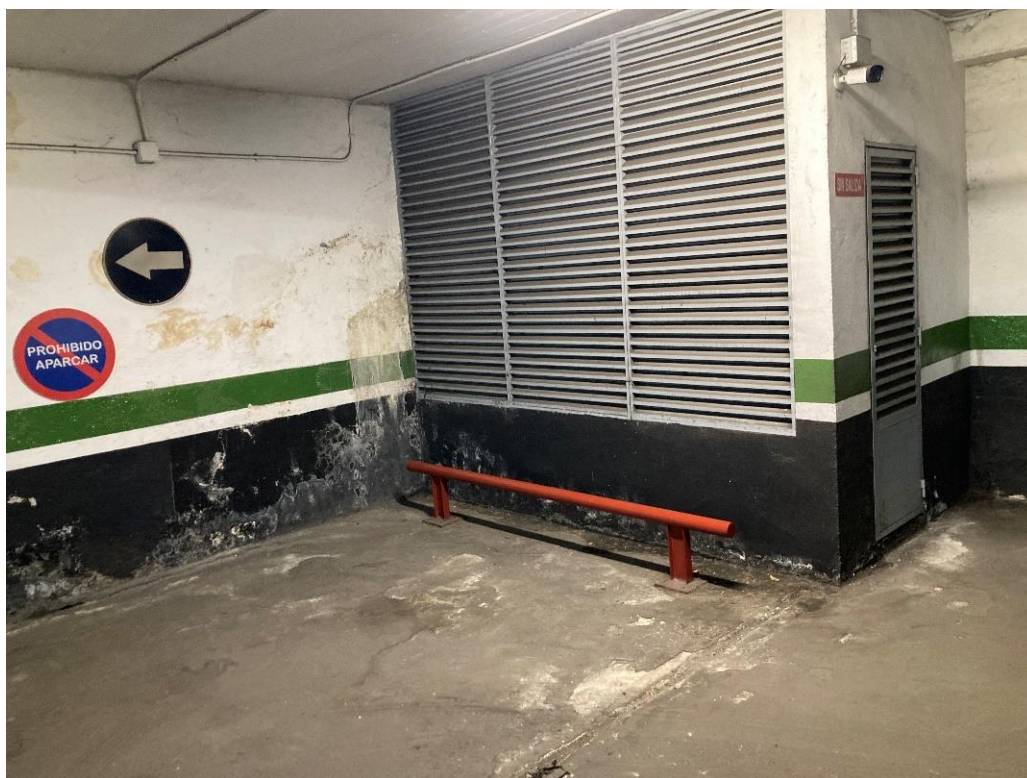
Fotografía n° 23: Humedades junto hueco instalaciones, planta S-4
