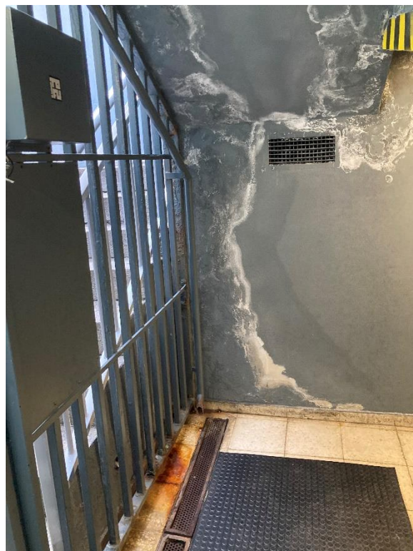
Fotografía nº 5: Humedades en pared junto a escaleras de acceso peatonal al exterior
