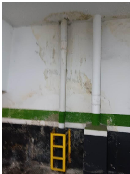
Fotografía nº 30: Humedades en forjado y muro en zona de junta con tubería
