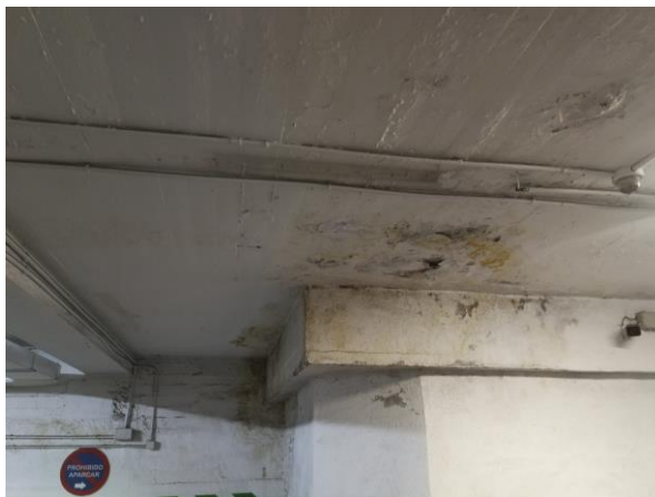
Fotografía nº 12: Humedades en forjado junto a hueco de ventilación natural
