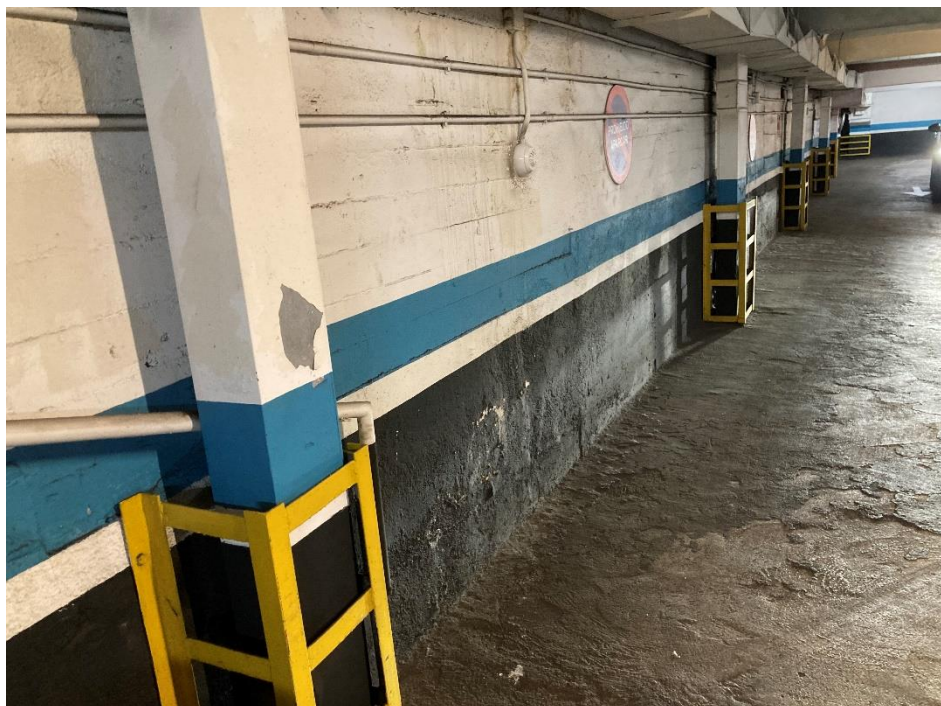
Fotografía nº 16: Desgaste de pavimento y manchas de humedad en muro
