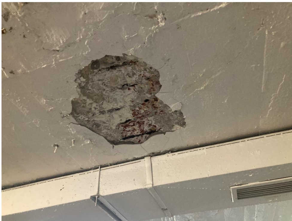
Fotografía nº 10: Detalle armaduras vistas losa cubierta
