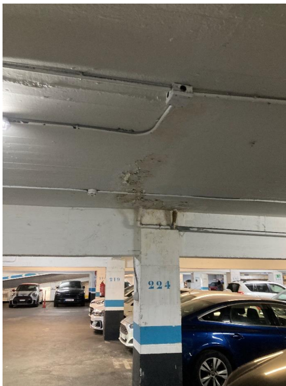
Fotografía nº 18: Humedades en forjado y pérdida de recubrimiento del hormigón en parcela 219.
