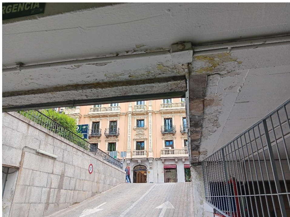
Fotografía nº 1: Humedades en forjado y muro en el acceso al aparcamiento
