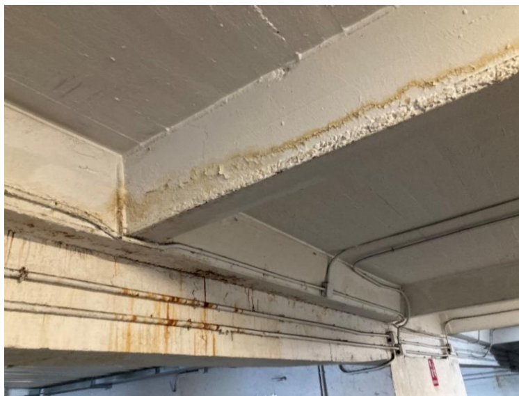
Fotografía nº 19: Humedades junto a la zona con chapa metálica a modo de falso techo
