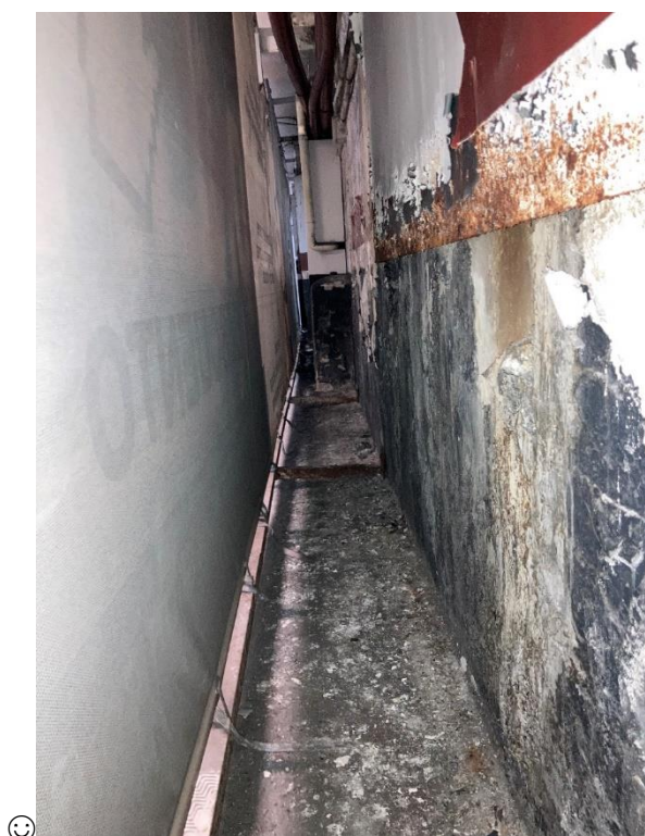
Fotografía nº 12: Humedades del muro perimetral zona- esquina inferior derecha, planta S-1
