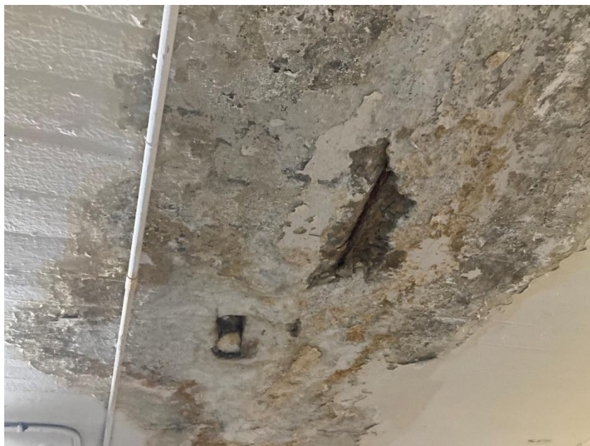
Fotografía nº 21: Detalle de armadura vista en viga en planta S-2, bajo rampa de acceso
