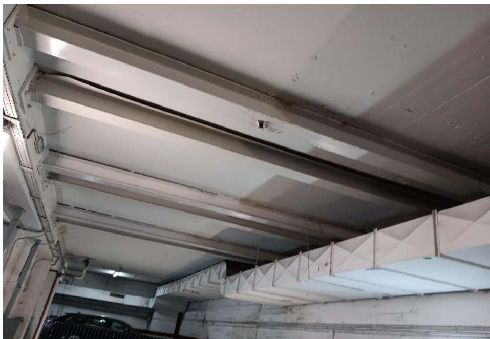
Fotografía nº 10: Vigas metálicas de refuerzo bajo forjado de cubierta. Descascarillado de pintura y algo de oxidación
