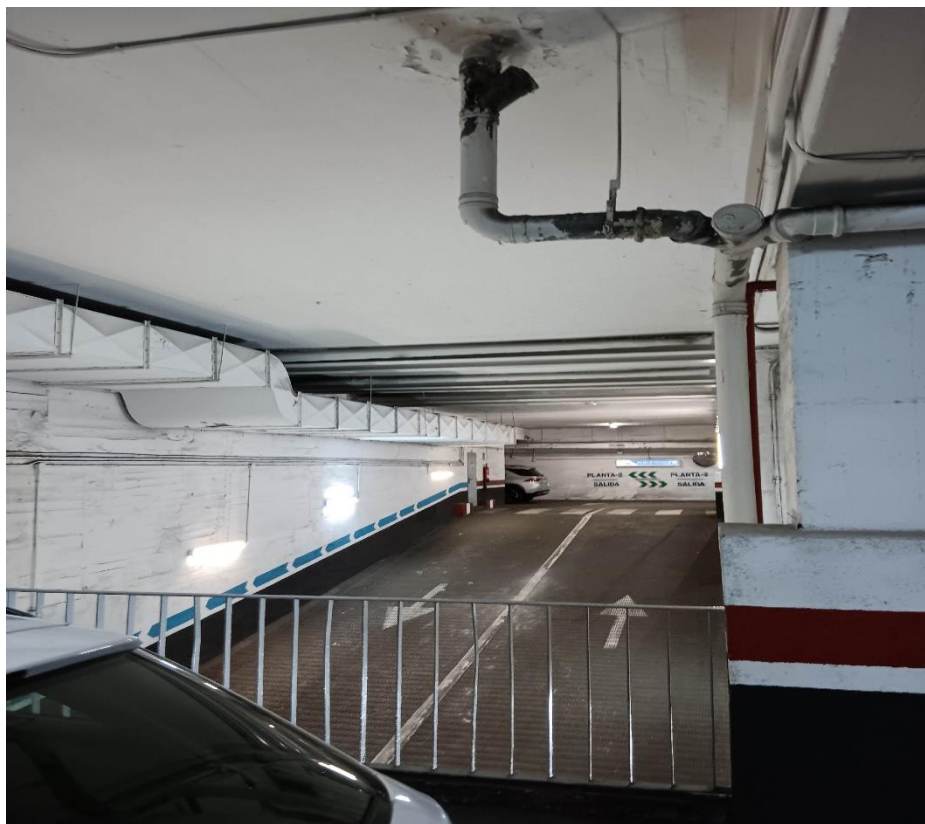
Fotografía nº 8: Rampa de bajada a Planta sótano -2. Humedades en de tubería
