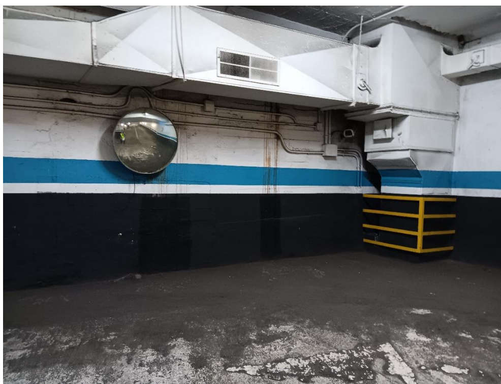
Fotografía nº 21: Filtraciones en muro. Desgaste de pavimento
