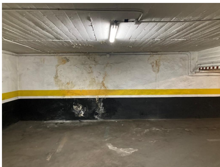
Fotografía nº 16: Humedades muro perimetral, zona- esquina inferior derecha, planta S-3
