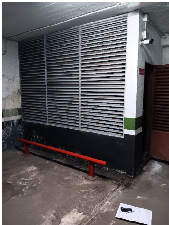
Fotografía nº 31: Humedades en muro y pavimento junto a hueco de ventilación
