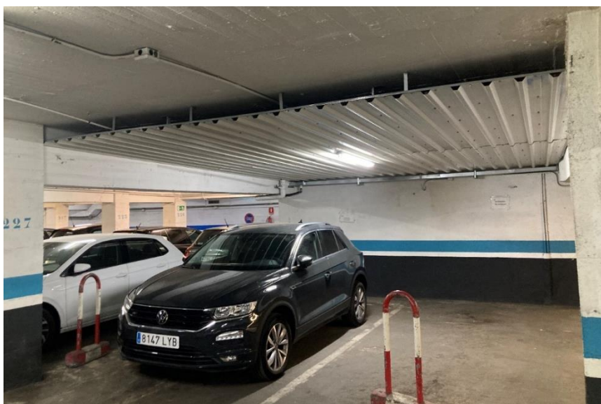
Fotografía nº 18: Chapa metálica a modo de falso techo bajo aseos planta S-1
