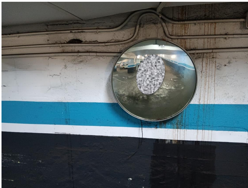
Fotografía nº 22: Filtraciones, grietas y pérdida de hormigón en muro. Mancha de filtraciones oculta con pintura
