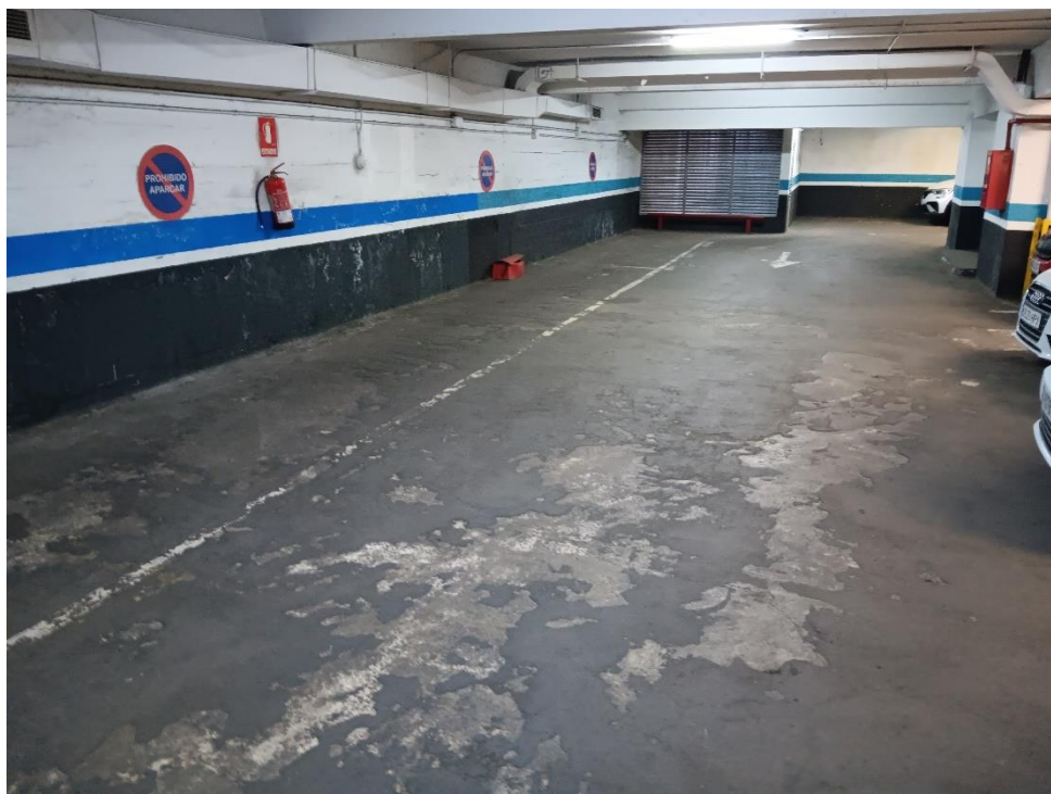
Fotografía nº 15: Desgaste de pavimento
