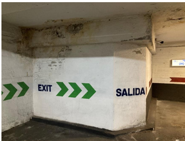
Fotografía nº 5: Humedades en forjado y paramentos junto a hueco de ventilación al exterior, planta S-1
