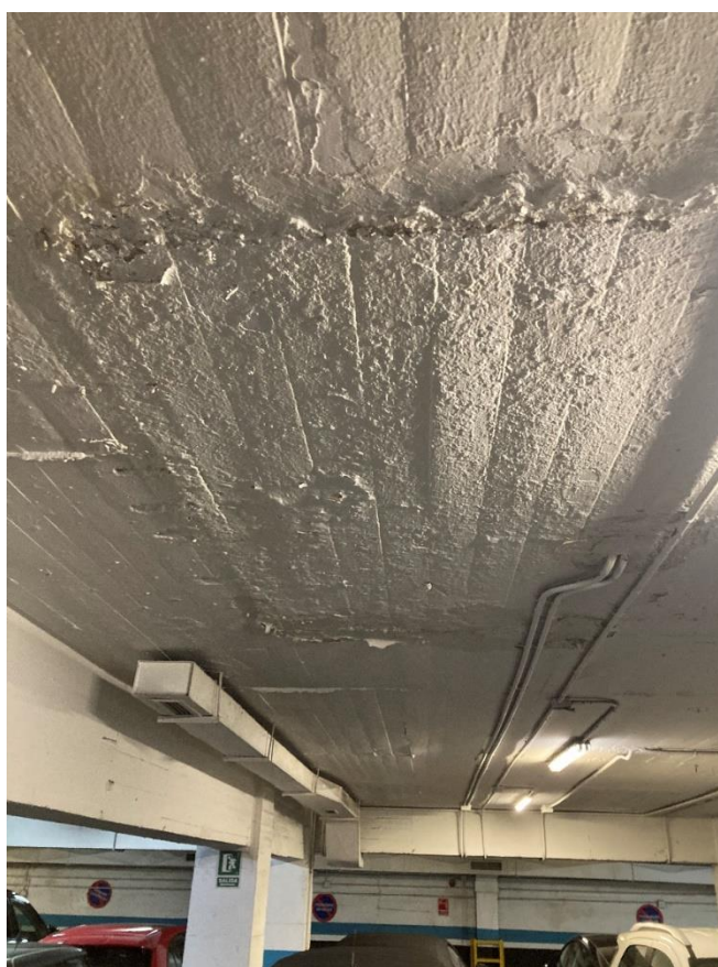
Fotografía nº 22: Humedades en forjado, planta S-2
