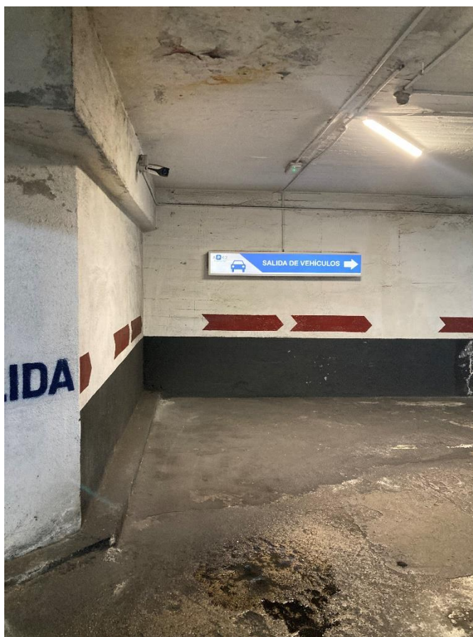
Fotografía nº 6: Humedades en forjados y paramentos junto a hueco de ventilación, planta S-1.
