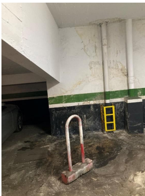
Fotografía nº 25: Humedades muro y solera, bajo cuarto de ventilación de planta S-3, planta S-4
