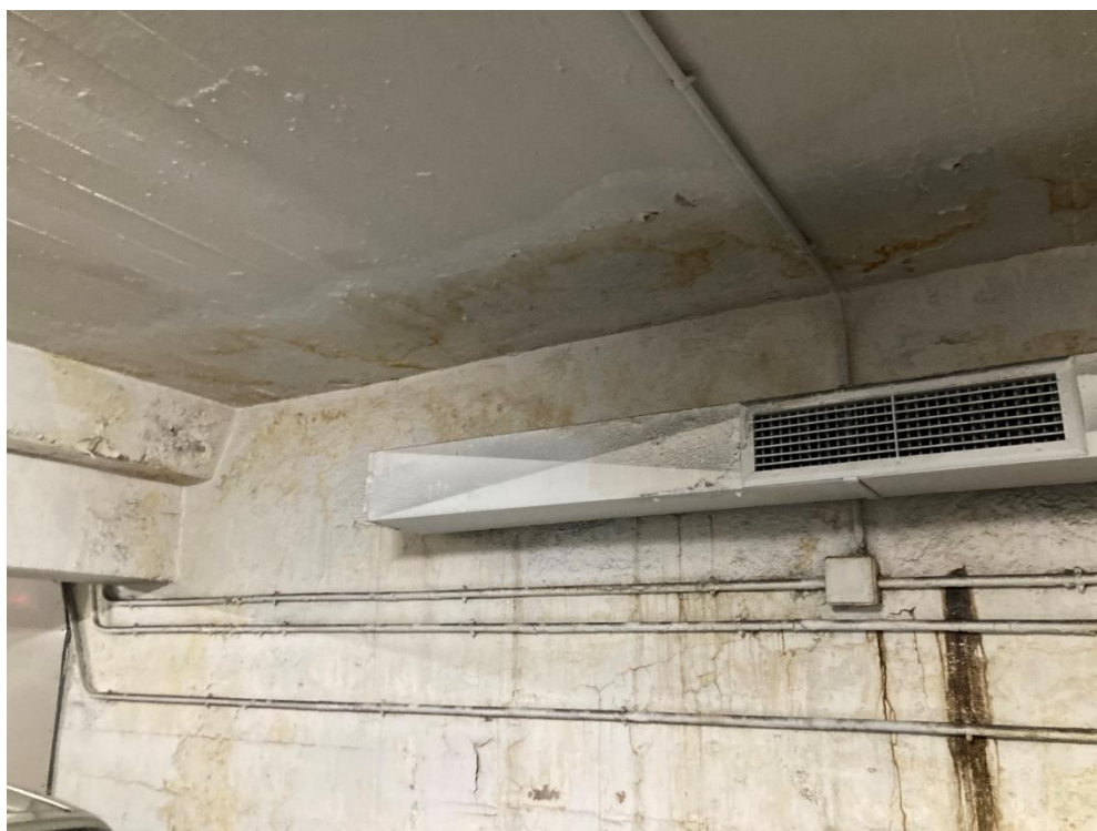
Fotografía nº 15: Humedades muro y forjado, zona- esquina inferior derecha, planta S-2
