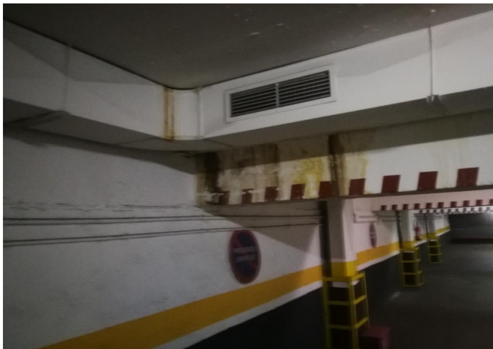
Fotografía nº 26: Humedad en viga
